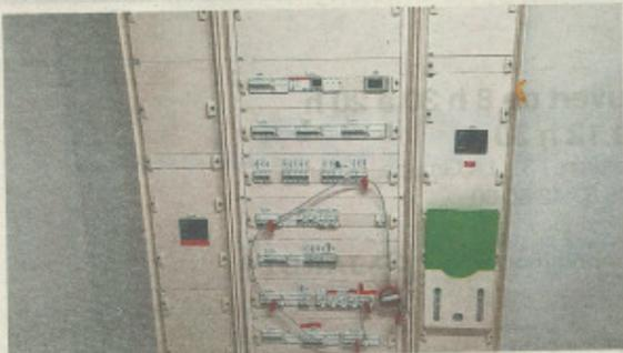
Un tableau général basse tension installé par Fauché. © Photo Fauché
